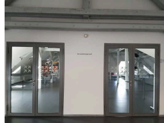
zwei identische Türen zum Veranstaltungsraum
