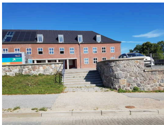
Treppe zum Vorplatz des Museums
